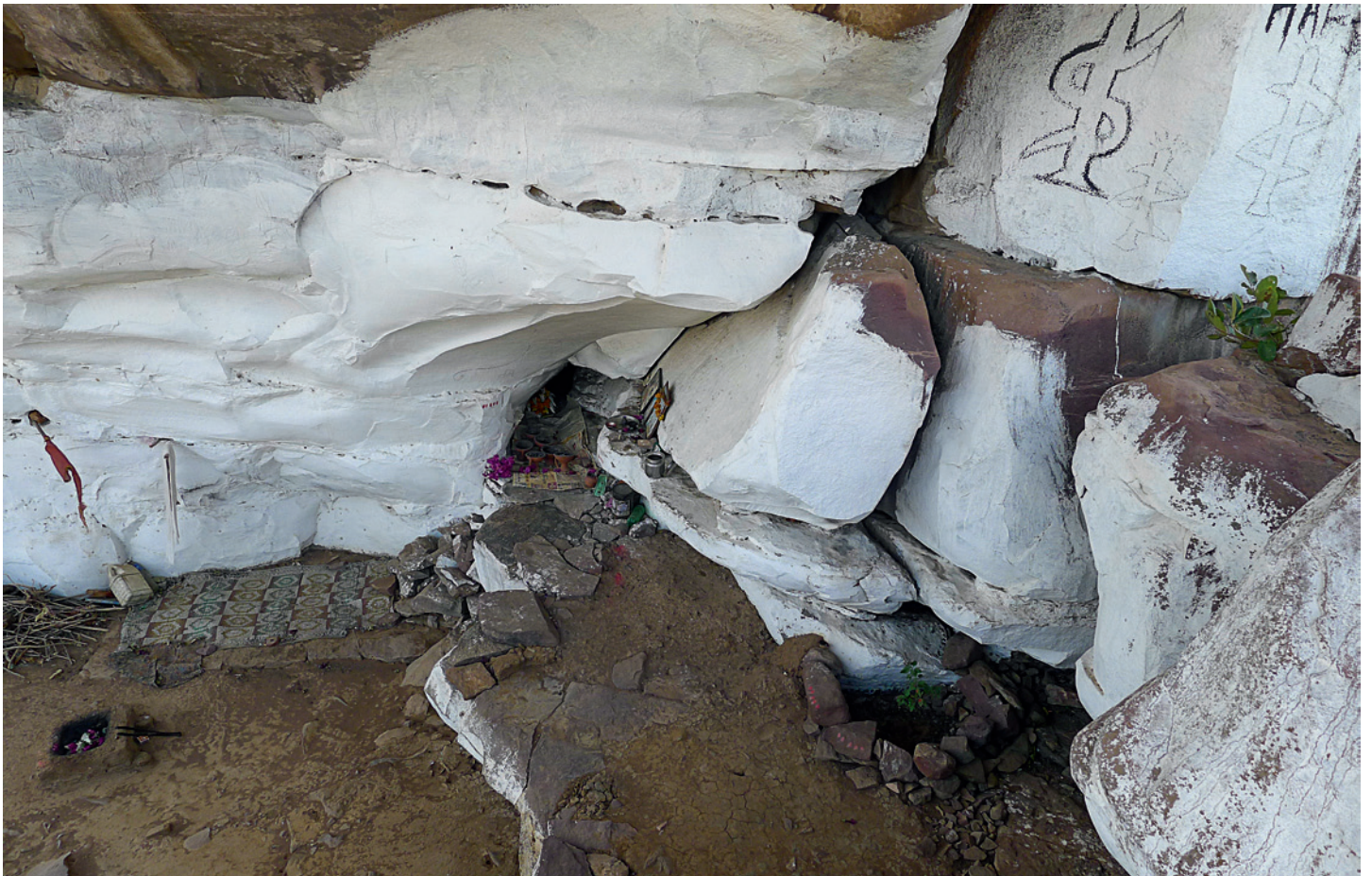
Fig. 6. Rocher de Kharwai : l'abri repeint est à présent habité par un ermite.
